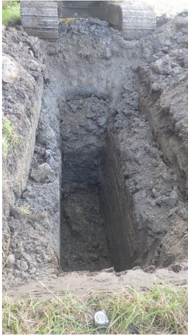
Figure 7 H:\2020-WW-102 Arklow Bank\Arklow Bank Tp Photos\TP207(1).JPG
