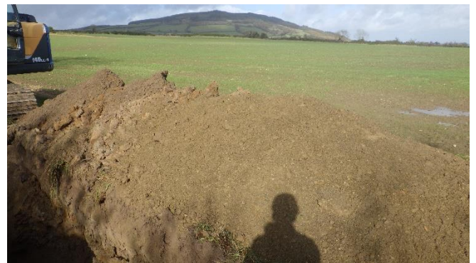
Figure 12 H:\2020-WW-102 Arklow Bank\Arklow Bank Tp Photos\TP210(2).JPG
