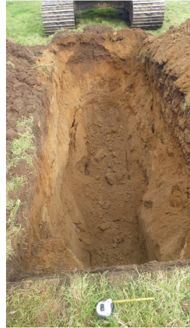
Figure 16 H:\2020-WW-102 Arklow Bank\Arklow Bank Tp Photos\TP221(1).JPG
