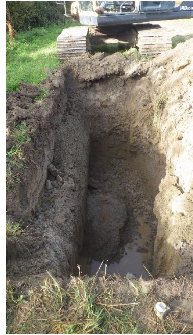
Figure 11 H:\2020-WW-102 Arklow Bank\Arklow Bank Tp Photos\TP210(1).JPG
