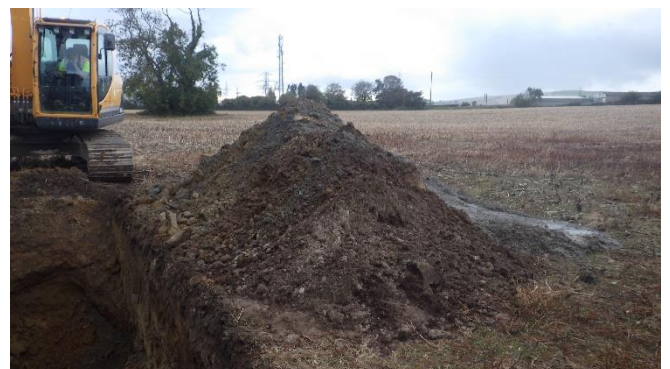
Figure 6 H:\2020-WW-102 Arklow Bank\Arklow Bank Tp Photos\TP203(2).JPG
