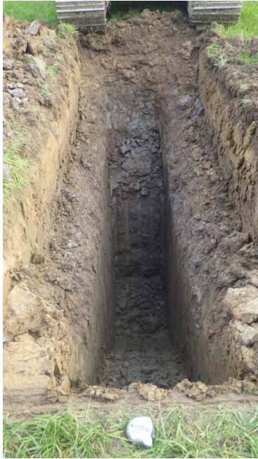
Figure 1 H:\2020-WW-102 Arklow Bank\Arklow Bank Tp Photos\TP201(1).JPG
