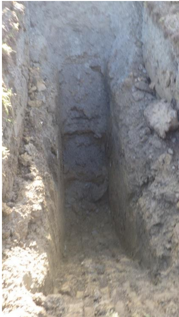
Figure 14 H:\2020-WW-102 Arklow Bank\Arklow Bank Tp Photos\TP220(2).JPG
