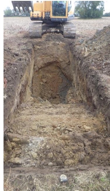
Figure 5 H:\2020-WW-102 Arklow Bank\Arklow Bank Tp Photos\TP203(1).JPG
