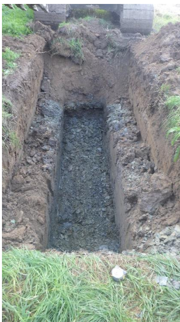
Figure 9 H:\2020-WW-102 Arklow Bank\Arklow Bank Tp Photos\TP209(1).JPG
