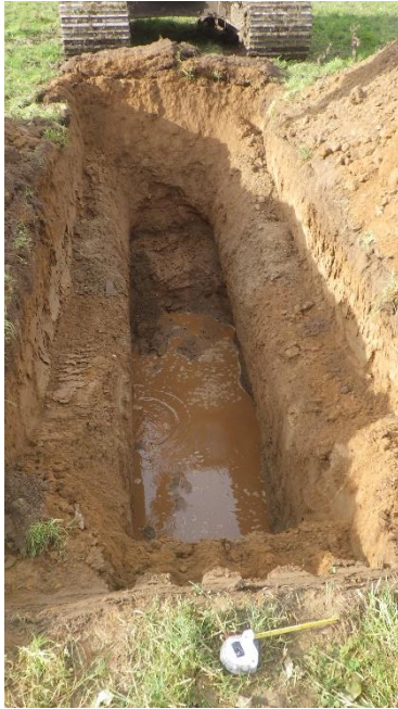
Figure 19 H:\2020-WW-102 Arklow Bank\Arklow Bank Tp Photos\TP222(1).JPG
